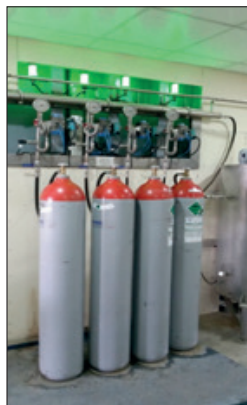
شكل رقم 10: أسطوانات الغاز ولوحة التحكم (مصنع التمور بالأحساء)
