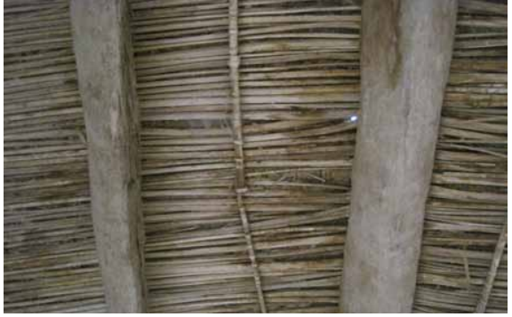
استخدام سوق وجريد النخيل في أسقف المنازل
