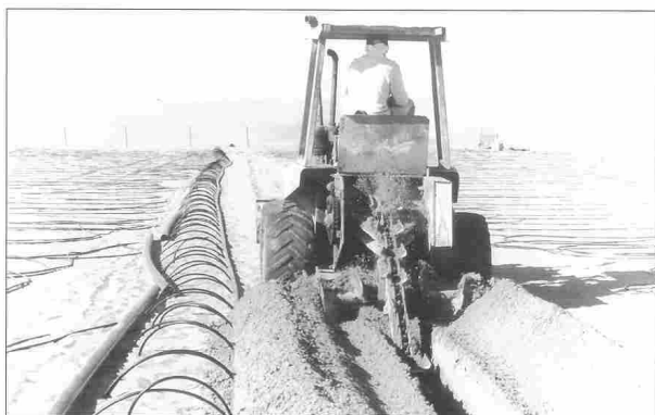
صورة ٨/٣، مزرعة نموذجية كاملة التجهيز، وفي الصورة معدة زراعية تقوم بالحفر لتجهيز شبكة ري حديثة في مزرعة أحد المواطنين في المنطقة الشرقية من إمارة أبوظبي.
