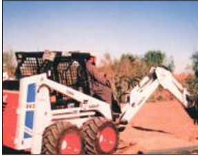
استخدام المعدات الحديثة لتمديد شبكات الري
