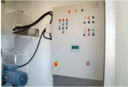
أجهزة السيطرة الموجودة في الجهاز لغرض السيطرة على درجة الحرارة والرطوبة وسرعة الهواء
